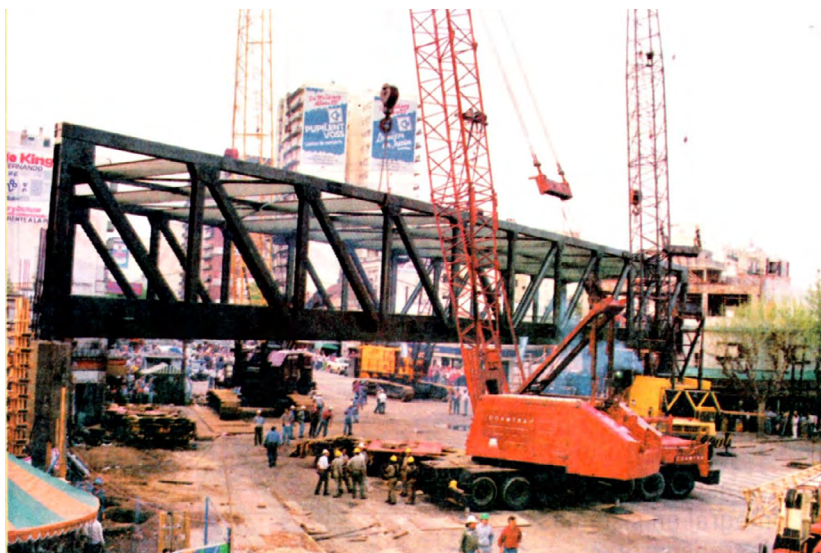
Figura 1. Realización de la obra de colocación del puente sobre avenida Maipú (Olivos)
